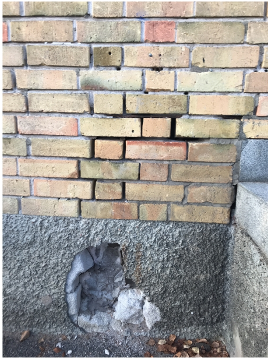
Tegelfasad som är i behov av renovering, ett klassrum där ventilationen inte lokaliserades samt håligheter i golv som kan öka risk för radon inomhus.
