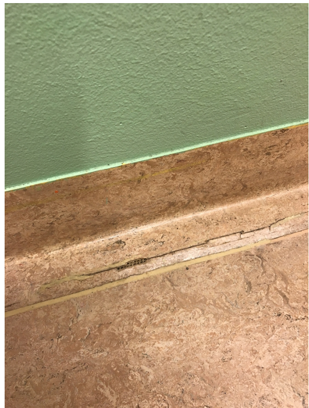
Tegelfasad som är i behov av renovering, ett klassrum där ventilationen inte lokaliserades samt håligheter i golv som kan öka risk för radon inomhus.
